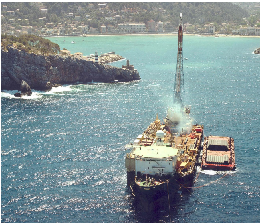
Tendido de la tubería submarina.
